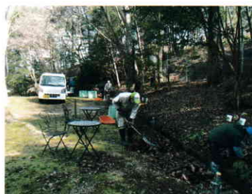
清掃活動(レストハウス裏の側溝)
